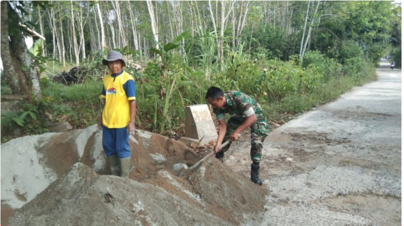
Babinsa Bantu Gotong Royong Pengecoran Jalan
