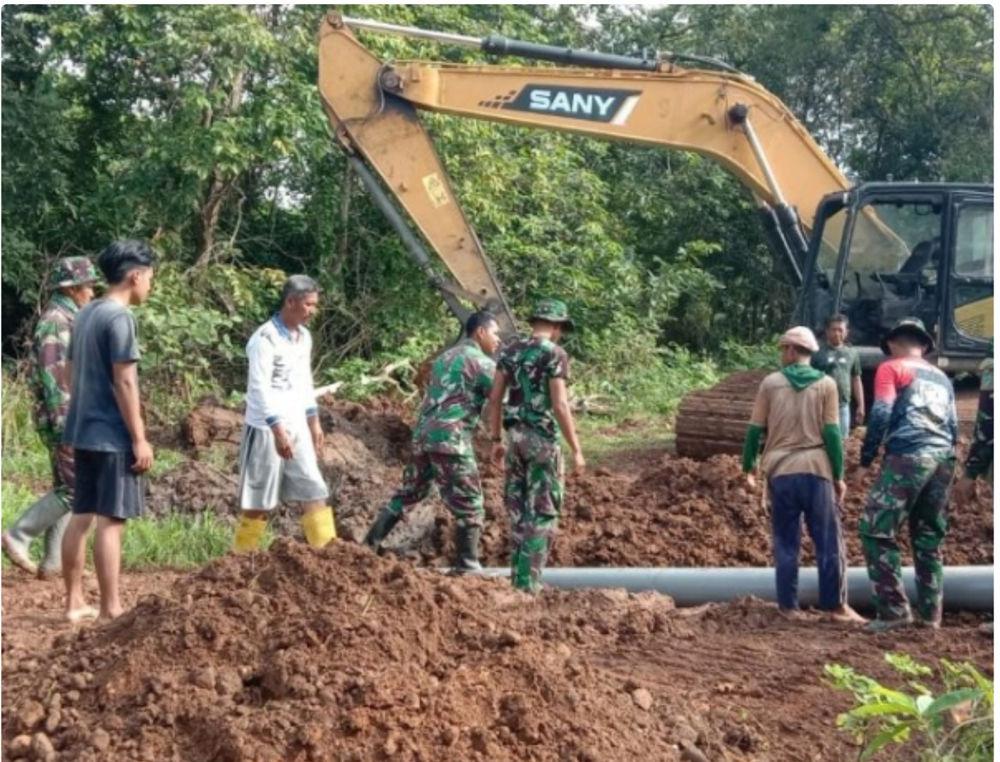
Pemasangan Pipa Saluran Air
