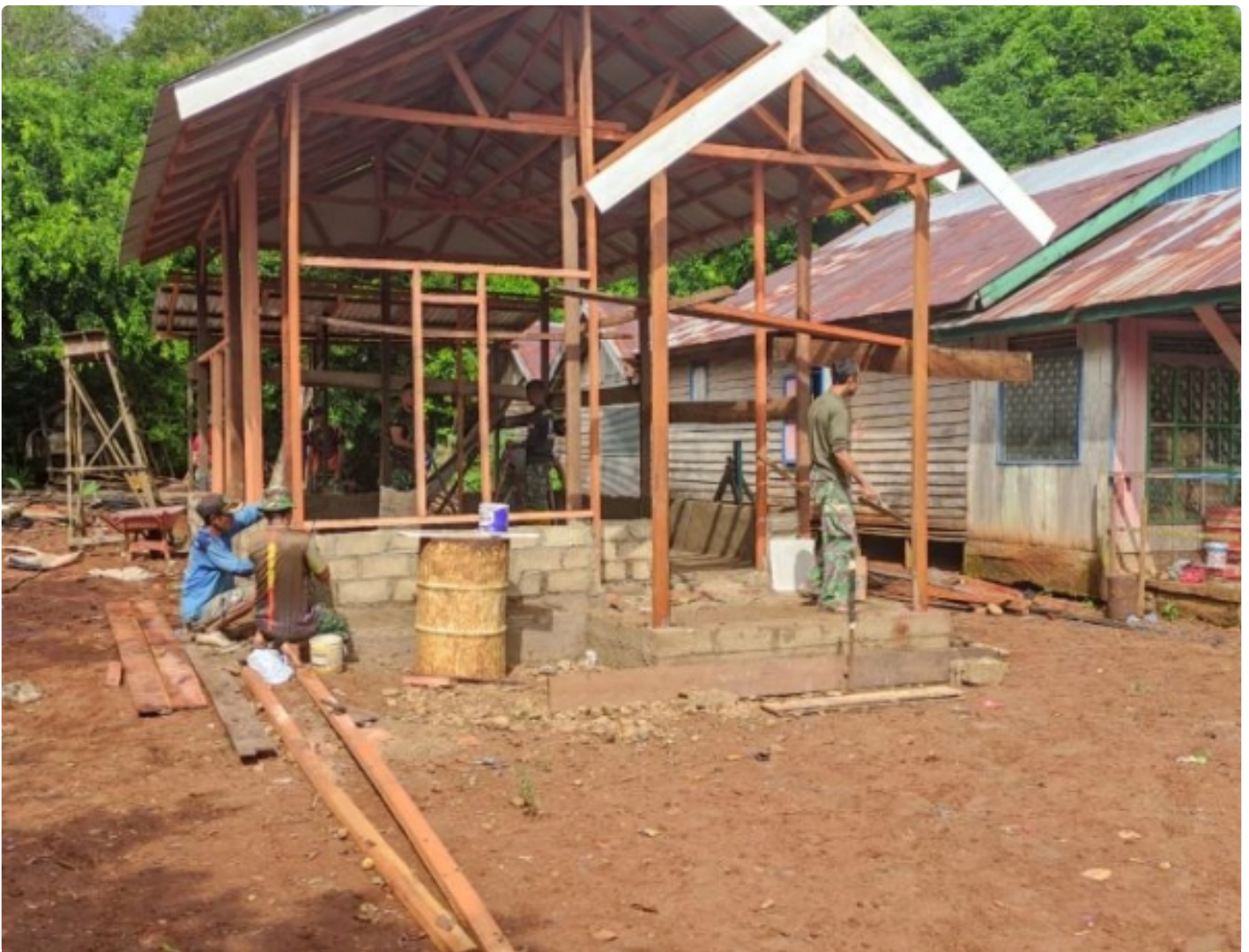
Atap Dan Tiang Teras Bedah Rumah Terpasang Program TMMD Kodim 1006/Banjar
